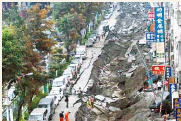
圖一：高雄氣爆事故後的現場
