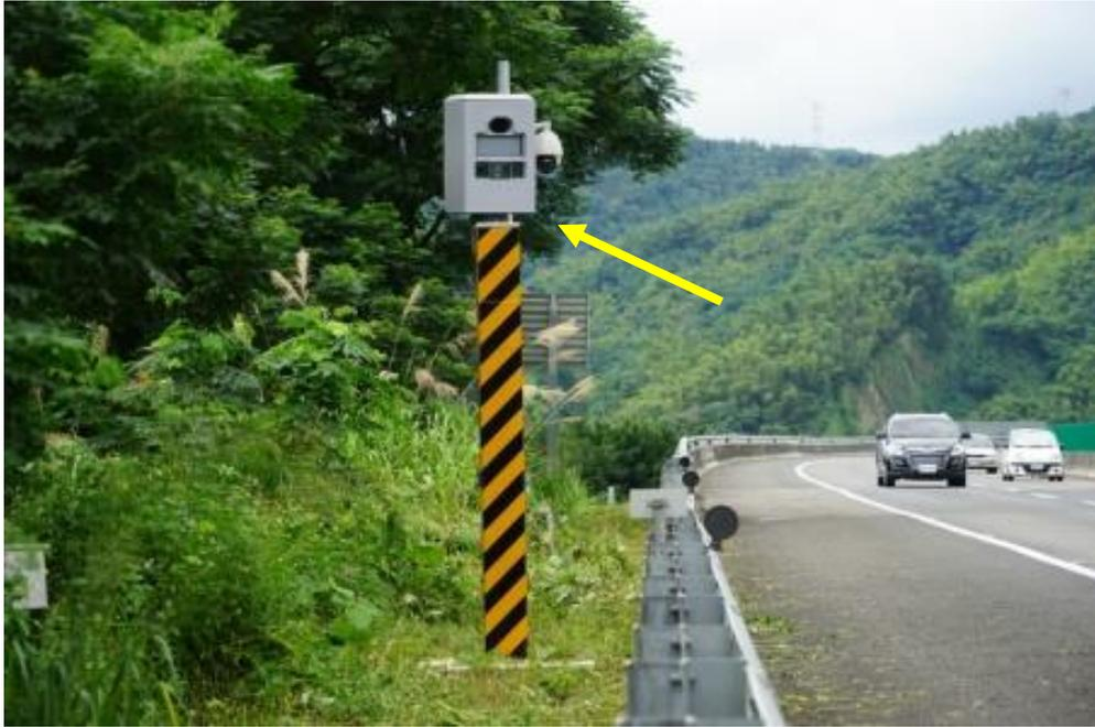
圖 5. 若車輛倒車觸發紅外線感測器，在檔桿降下的同時照相機(黃色箭頭處)也會立刻擷取影像，以便依法開罰。
